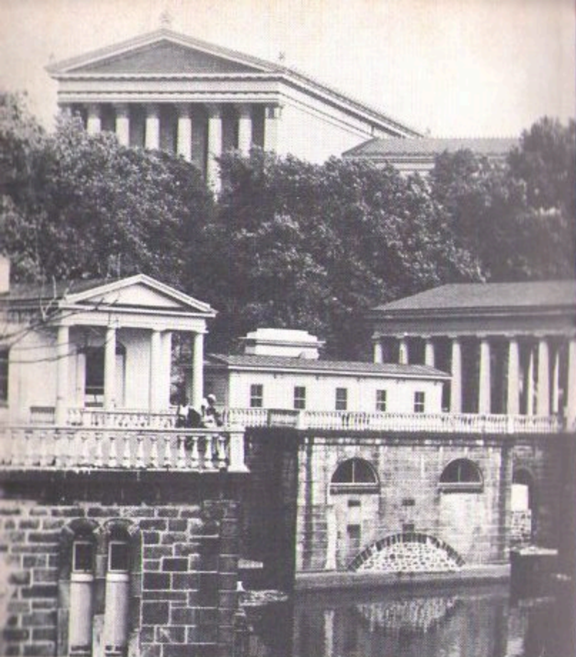
Las Obras de Abastecimiento de Agua de Fairmount, en Filadelfia, Pensilvania. Le imponemos la forma de lo viejo al contenido de lo nuevo. La enfermedad subsiste.
